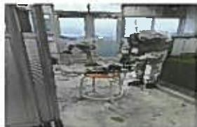
5. 切断した箇所を半自動溶接で溶接する。
