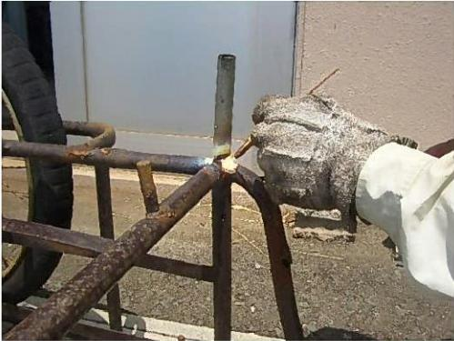
②新たに部品を準備し、ガス溶接で接合する
